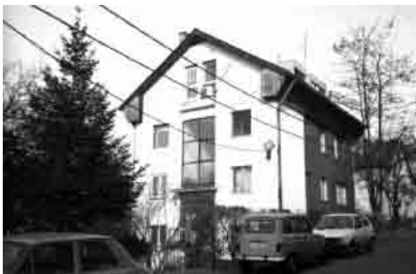
Sl. 4 – Nadgradnja stambenog objekta u ul. Zmaj Ognjenog Vuka u Beogradu. Primer vertikalnog proširenja dva stana na drugom spratu.
