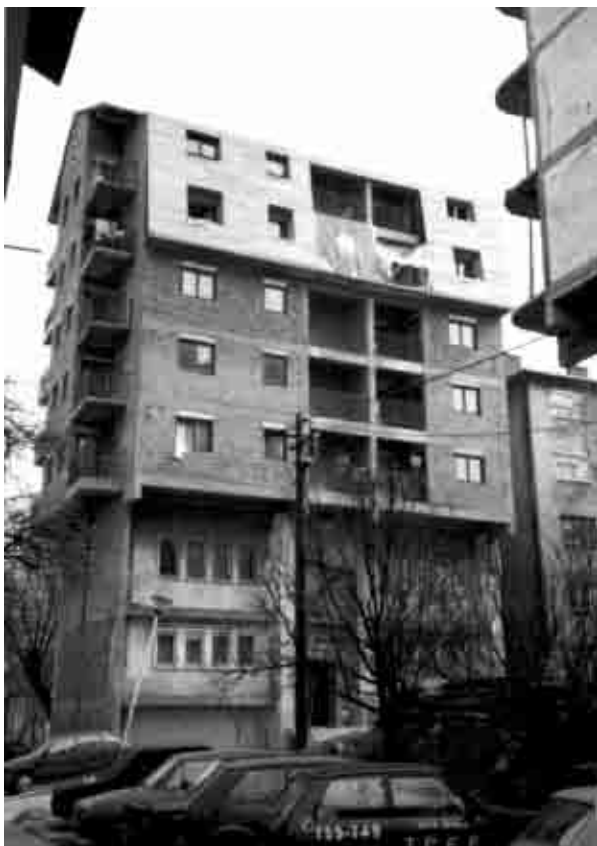
Sl.22 – Jedan od više objekata P+1 u Sretničkoj ul. na Karaburmi, koji su nadgradjeni sa pet i po novih etaža, uz bezobrazno izlaženje dodatnih spratova izvan gradjevine linije po celoj širini objekta
