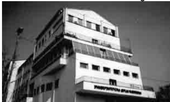
Sl.2 – Necivilizovani krpež iznad Dečje klinike u Tiršovoj ul. u Beogradu. Ova zgrada, čiji je autor Prof. M. Zloković, je smatrana jednim od najlepših primera zdravstvenih objekata rane Moderne u Evropi.
