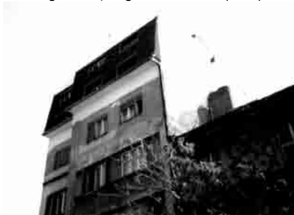
Sl.19 – Primer substandardne nadgradnje u Novopazarskoj ul. koja svojim nekvalitetom degradira ceo objekat.
