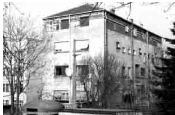
Sl.12 – Primer haotične nadgradnje bez ikakvih intervencija na derutnoj fasadi i bez poštovanja postojeće arhitekture u ul. Viktora Igoa na Senjaku.
