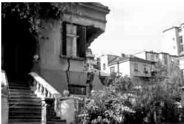
Sl.15 – Neobezbedjena gradnja u ul. Internacionalnih brigada 65, dovela je do destrukcije susedne stambene zgrade.
