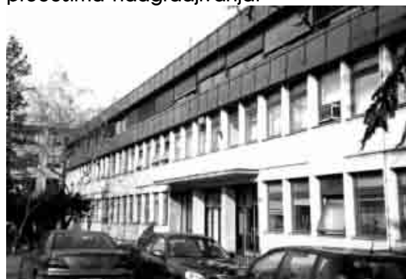
Sl.14 – Kontrastna i znalačka nadgradnja zgrade GP “Ratko Mitrović” u ul. Koste Glavinića u Beogradu. Oblikovni kvaliteti nisu degradirani.
