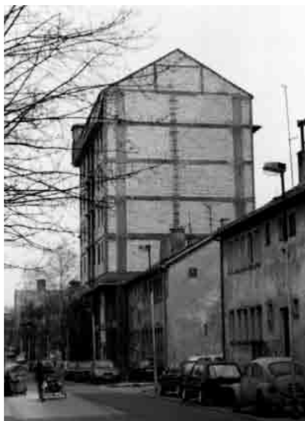
Sl.16 – Apsolutni rekord: 5 i po nadgradjenih etaža iznad skromnih kućica P+1 u Srnetičkoj ul. na Karaburmi. Ako i pretpostavimo da su svi imperativi vezani za bezbednost zadovoljeni ( a verovatno nisu), ostaje činjenica da je broj donaćinstava UČETVOROSTRUČEN, što dovodi do potpunog poremećaja svih urbanističkih parametara.
