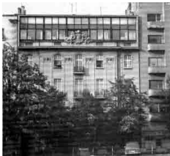
Sl.1 – Nadgradnja stambeno-poslovnog objekta u Njegoševoj ul. u Beogradu (M.Mitić i/ili L.Lenarčić)
