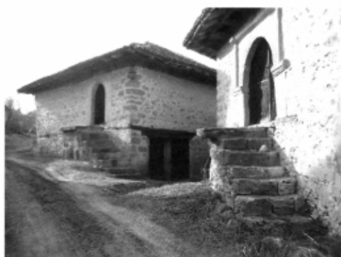
Изглед постојећих камених здања
