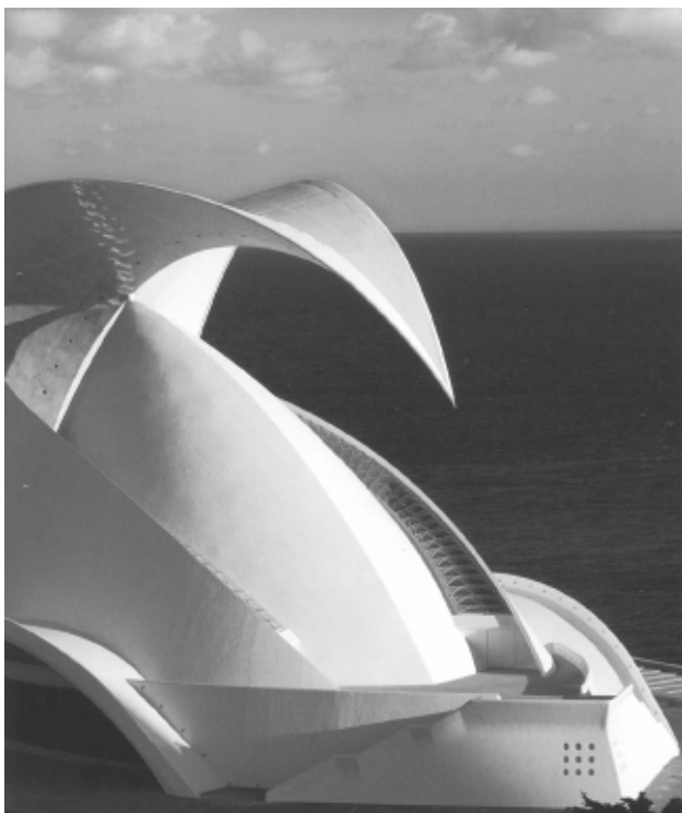
S. Calatrava: Tenerife Auditorium Santa Cruz, 1997–2003
