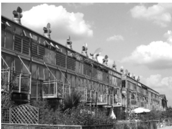
(50) – B.Dunster: Stambeno naselje BedZED (Bedington Zero Energy Development), Engleska, 2000/02. U ovom naselju, korišćeni su reciklirani građevinski materijali, a potrošnja spoljnih potrošnih energetskih izvora se praktično svodi na nulu.
