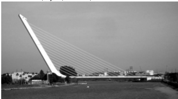
Puente del Alamillo, Sevilla, Španija, 1992
