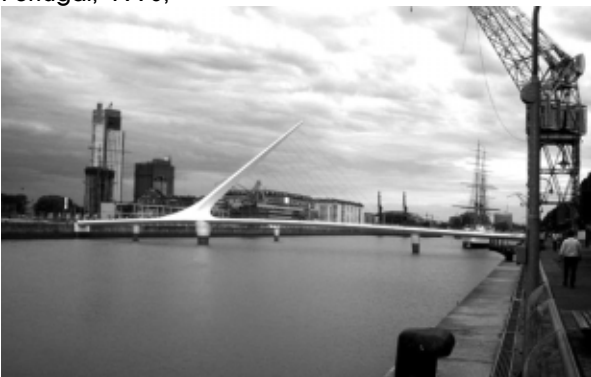
Puente de la Mujer, in the Puerto Madero barrio of Buenos Aires, Argentina, 1998
