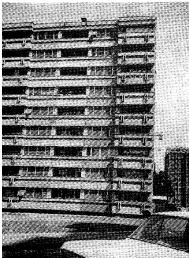
Vera Živić-Hadžić, Zorana Luković: Stambena zgrada u naselju "Sajmište", Niš
